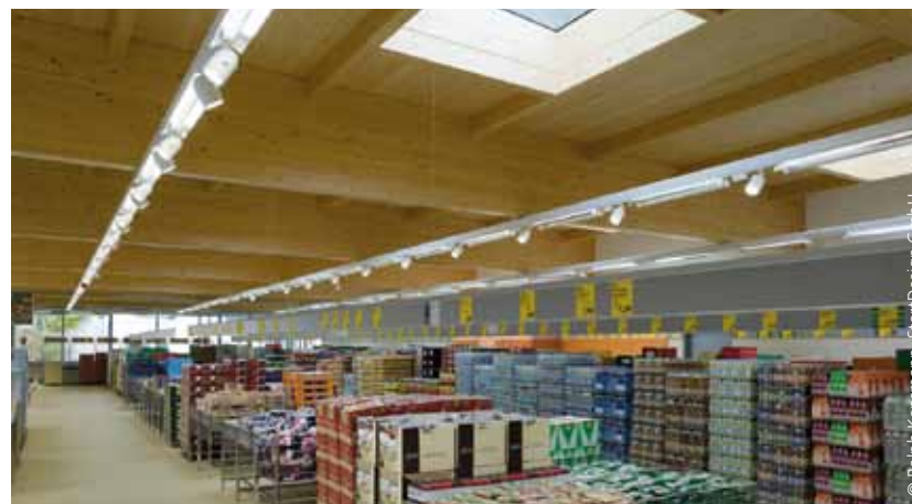
Tageslichtkuppeln im Dach reduzieren den Strombedarf für Beleuchtung.
