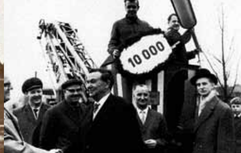
1964: Die 10.000ste elektrische Straßenlaterne
