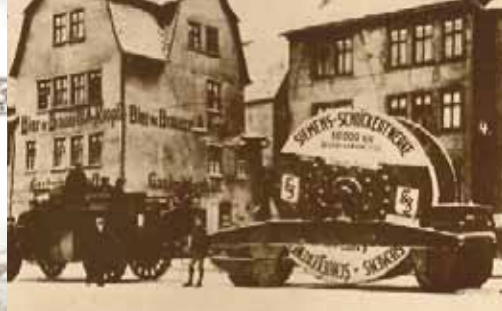
1923: Transport eines 60.000 Volt-Kabels
